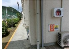
本館教職員出入口横
